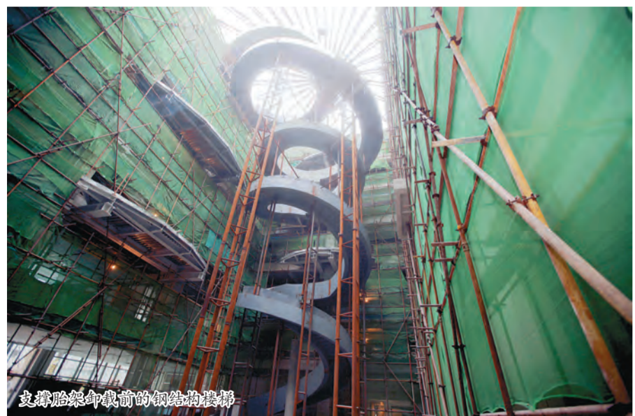
道层在整个中庭的钢结构均封顶
