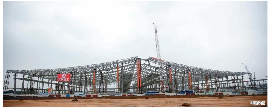
本报讯(记者李晓宇 通讯员岳跃磊) 9月25日,随着最后一根桁架梁被吊至 32米高空,并完成拼装焊接,备受关注的 长沙国际会展中心的E3、E4展馆率先实 现结构封顶。长沙国际会展中心位于长 沙县黄兴镇——高铁新城片区核心区 域,是集展览、会议、商务、购物、娱乐等 为一体的综合性会展城。项目总用地面 积约800亩,设12个单层展馆、2个登陆 厅,展览面积约26万平方米,可提供8652 个展位。由公司承建的长沙国际会展中 心一期二标段工程是公司在长沙地区中 标的第四个工程,总建筑面积约8.7万平 米,主要包括四个展馆,两个连接厅,西 侧连廊,室外展场、道路、管网、景观、园 林绿化及展馆场。预计另外两个展馆 E1、E2 馆将于10月底完成主体结构封 顶,明年8月底实现竣工。到明年年底, 这座位于浏阳河畔、长沙南站附近的长 沙最大会展中心将正式对外迎客。
