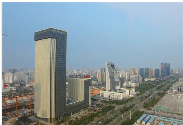
**本报讯 (通讯员 柳洋 周也)** 200米高的海南大厦工程共使用钢筋23900吨、支搭模板489852平米、浇筑混凝土145305立方、钢结构吊装25000吨,最终该工程荣获中国钢结构金奖和海南省“绿岛杯”奖,以崭新的形象为北京建工集团在海口树立了超高层施工的品牌,成为继新海航大厦之后屹立于海口国兴大道上的“新地标”。
