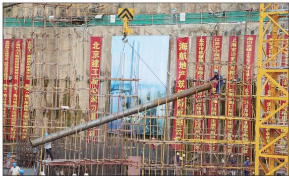
厂,紧邻基坑南侧存在一条已运营26年的混凝土材质DN1200主供水管道,给基坑施工带来了极大的考验。这可不是一般的风险,稍不注意就会造成水管部分沉降断裂,因此必须严格控制施工方案,确保万无一失。因为这条水管的存在一个原本的正常的工艺,变得犹如精密的外科手术一般。术前准备——为了尽可能杜绝工程隐患,项目与水厂运营单位多次沟通商议,保护方案一改再改,力求保全重要设施;术中——施工人员在施工作业过程中,需要时刻监测水管的沉降情况并向水厂报告,一旦有丝毫的异样就必须停工采取措施。
