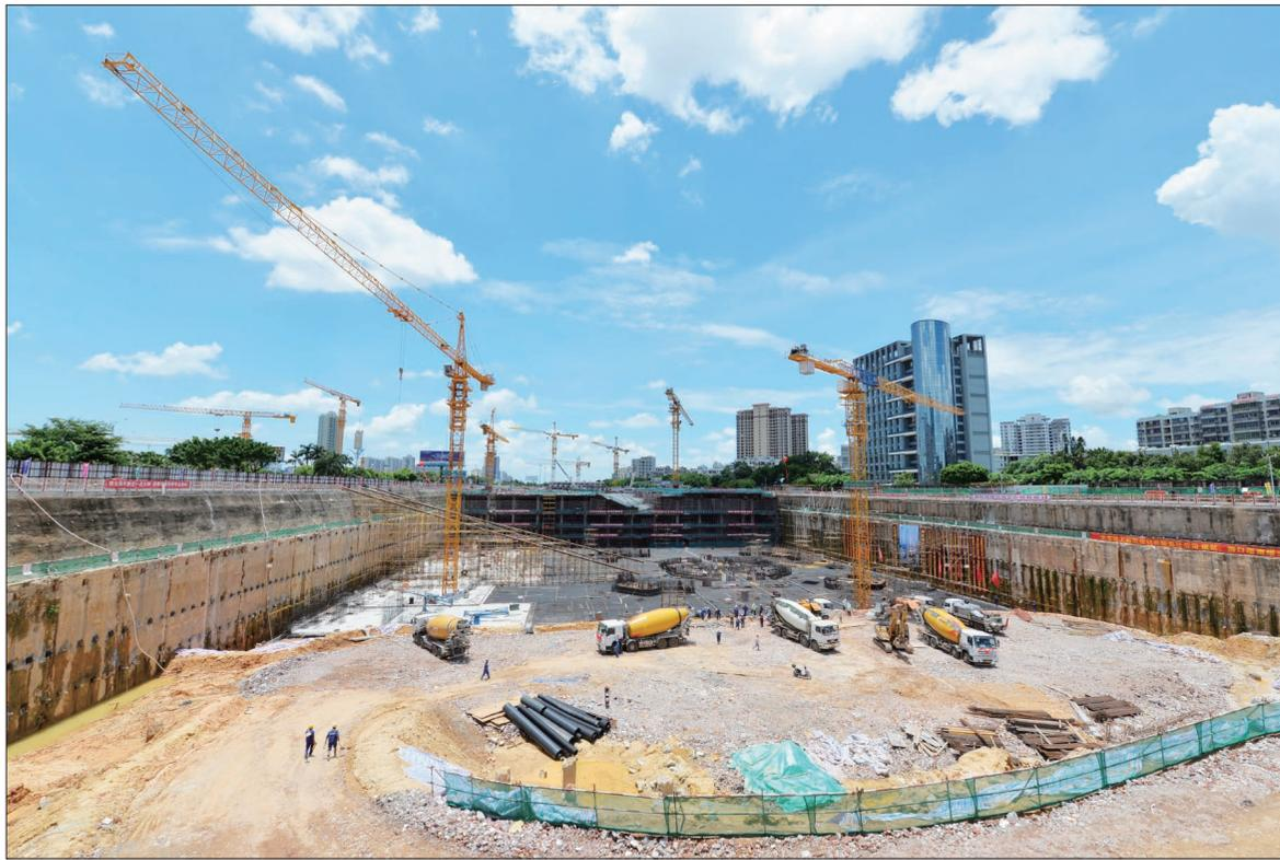
本报讯(通讯员 马亚丽 王静雪 马淑丽 张文强 张德鹏) 7月9日,由北京建工集团施工的428米的海南第一高楼——海口双子塔·南塔工程塔楼筏板基础单次近4万方混凝土浇筑施工任务拉开序幕。下午13时36分,海航地产总裁杨猛先生一声令下,第一车混凝土通过溜槽奔而下,海口双子塔·南塔大体积混凝土浇筑正式开始。
