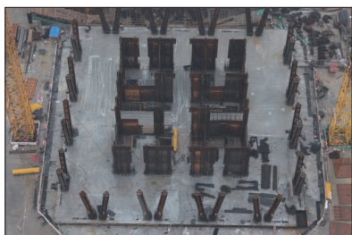
钢结构开始吊装; 全面冲出正负零
