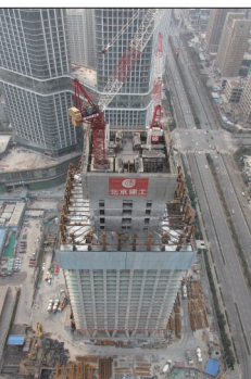
塔吊转换; 工程整体突破100米
