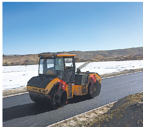
现场正式道路取代临时道路。
