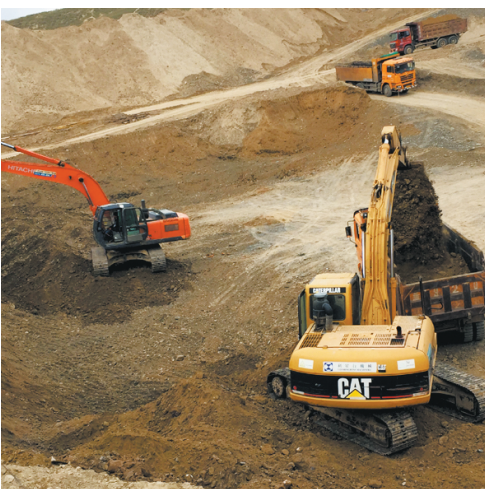
现场采用装土速度提升50%的360型挖掘机。节约成本20%。
