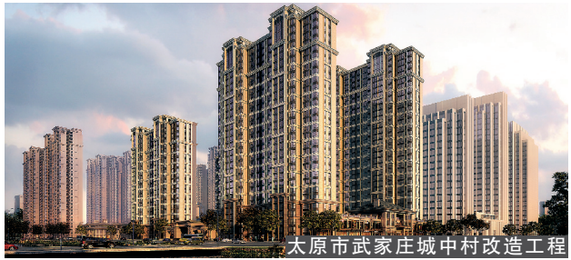
太原市武家庄城中村改造工程
