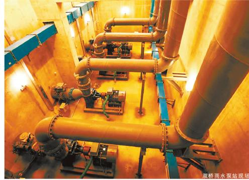
双桥雨水泵站位于北京市朝阳区双桥路与京秦铁路交汇处。工程主要包括：新建雨水管道1460米，土工坑14个，新建雨水口140个，新建泵站1座，建设调蓄池1座，容积2300立方米，进排面积1536.6平方米，新增水泵4台，新增提升能力16立方米/秒，改造供电系统。目前该工程已完成竣工结算，除质量保留金外，其余工程款已全部收回，项目整体收益较大。
