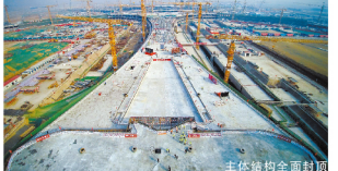
主体结构全面封顶
