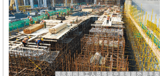
国庆节期间施工人员抢抓中南指廊外脚手架
