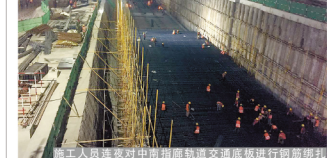
施工人员进行中南指廊轨道交通底板进行钢筋绑扎
