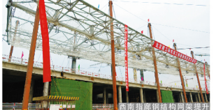
西南指廊钢结构架梁提升
