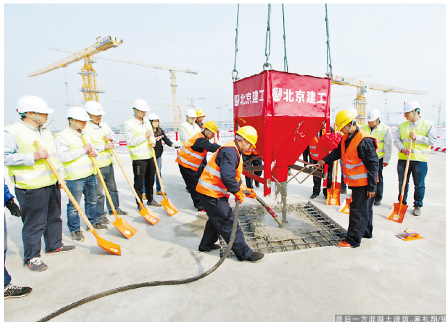
最后一方混凝土浇筑，顺利封顶
