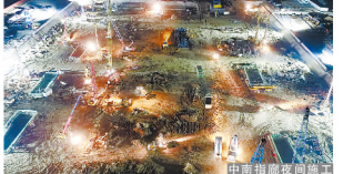
中南指廊夜间施工
