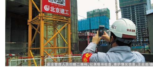
安全员利用手机扫描二维码，采集塔吊吊钩、维护情况信息，王启超摄
