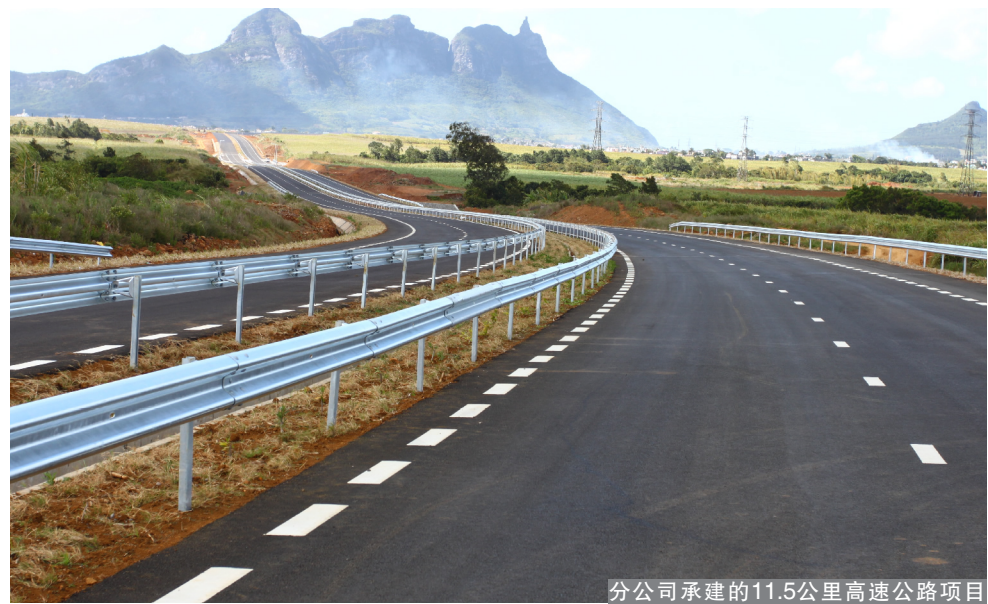
分公司承建的11.5公里高速公路项目
