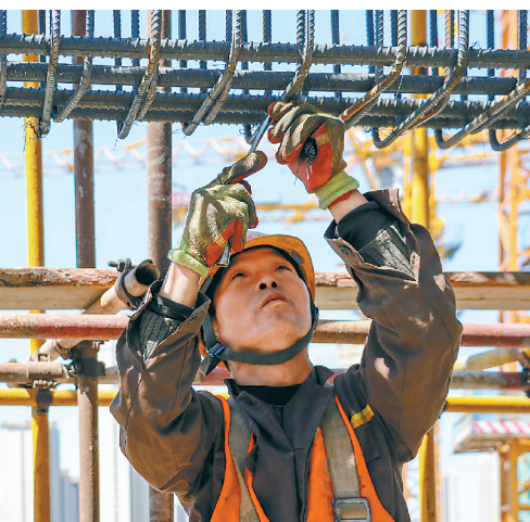
付振京 六建集团百子湾保障房工程钢筋工
