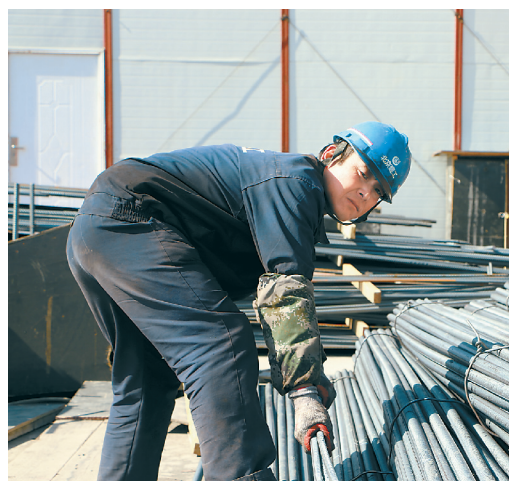
王洪全 国建集团鲜活农产品流通中心工程钢筋工
