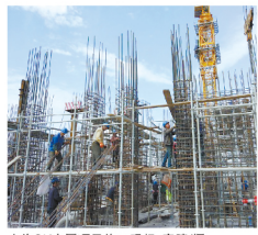
长沙C2项目施工现场,高轸/摄
