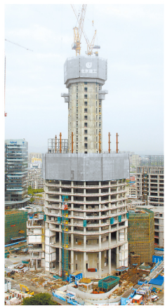
宁波SK大厦项目5楼外架,张兴博/摄
