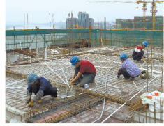
长沙C2项目施工现场,王启迪/摄
